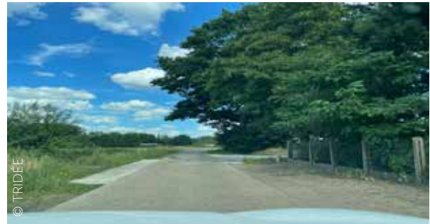
Oud-Turnhout. Plaatselijke verbreding van de berm zodat grotere voertuigen de bocht kunnen nemen en elkaar kunnen passeren.
