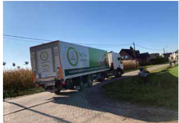
Retie. Een lokale weg met vrachtverkeer dat bestemming heeft in het gebied. Door het ontbreken van belijning en markeringen heeft de weg de uitstraling van een landelijke weg voor lokaal gebruik. Dit stimuleert gelijkwaardig gebruik.
