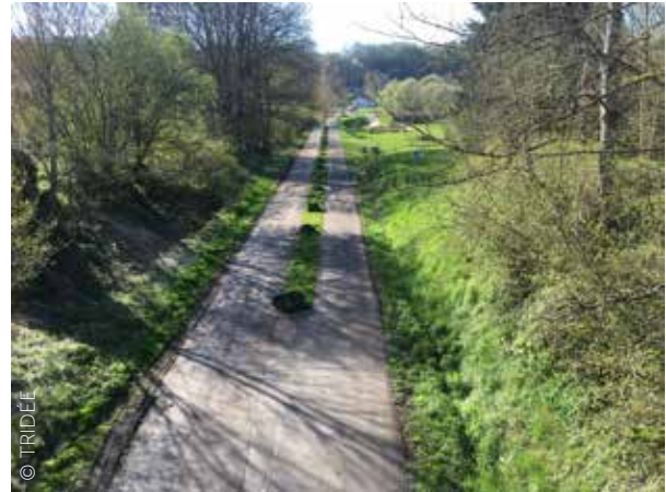
Houyet. Blokken in het midden verhinderen ongewenst gebruik door auto's.
