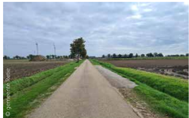
Retie. Passeerplaats door halfverharding van de berm.
