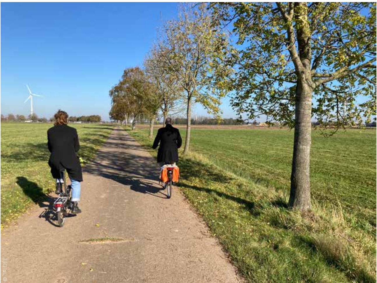
Fietsvriendelijk profiel: rijbaan en berm op gelijke hoogte, stevige berm, goed wegdek. De rijbaan is niet breed maar door de lage verkeersdruk is dat ook geen probleem.
