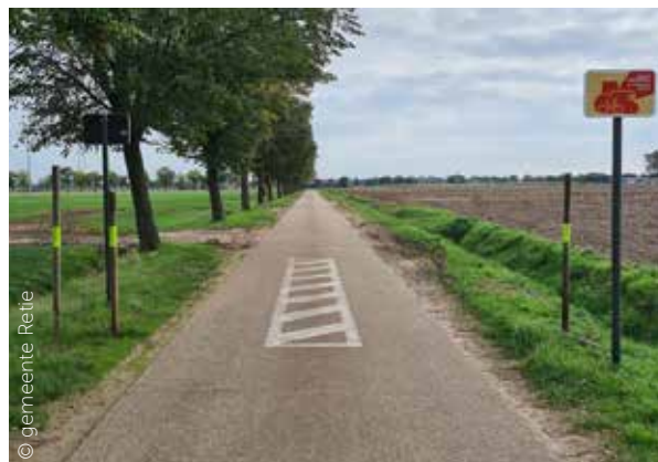
In Retie werd een poorteffect gesimuleerd via een proefopstelling: verandering van wegdek door grasdals op de locatie van de gearceerde markering, versmalling van het wegbeeld door objecten langs de weg en sensibilisering door het bord Gedeelde Landbouwwegen.
