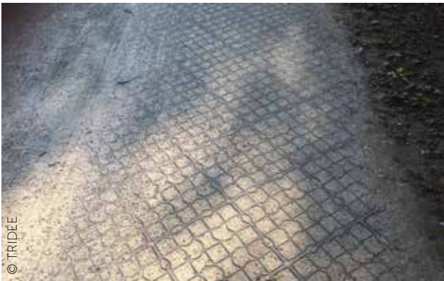
Links: Voorbeeld van een versteviging van de berm met matten.
